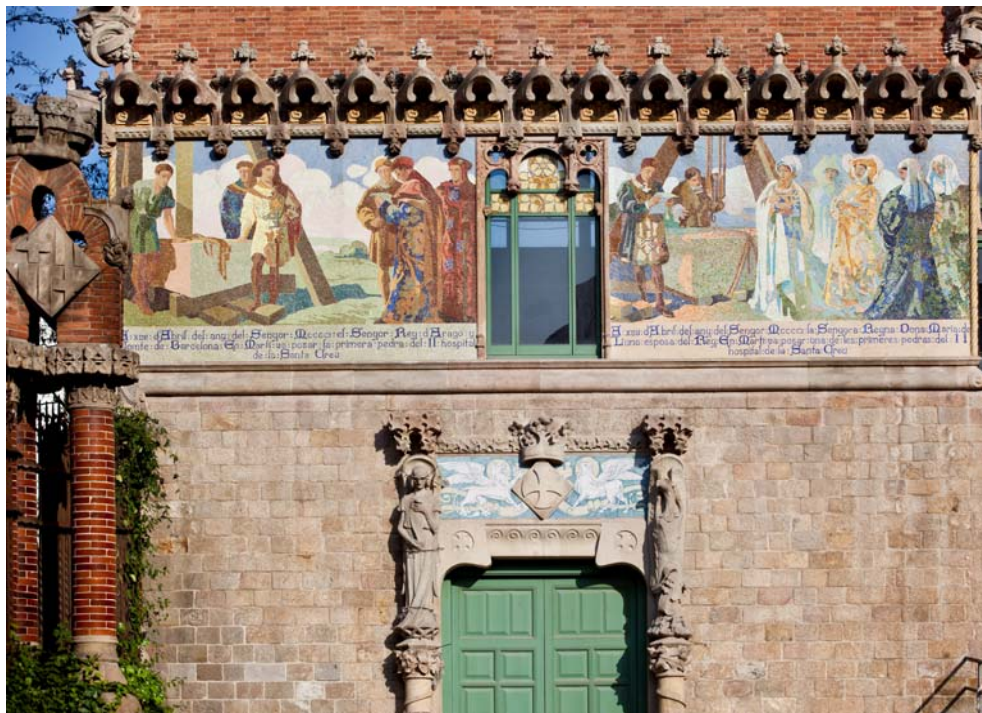
Detall d'una de les façanes del pavelló de l'Administració.
