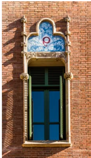
Façana del pavelló de Sant Leopold.
