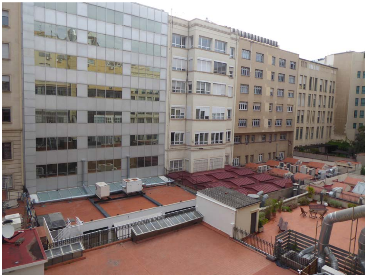
VISTAS DES DEL INTERIOR AL PATIO DE MANZANA
