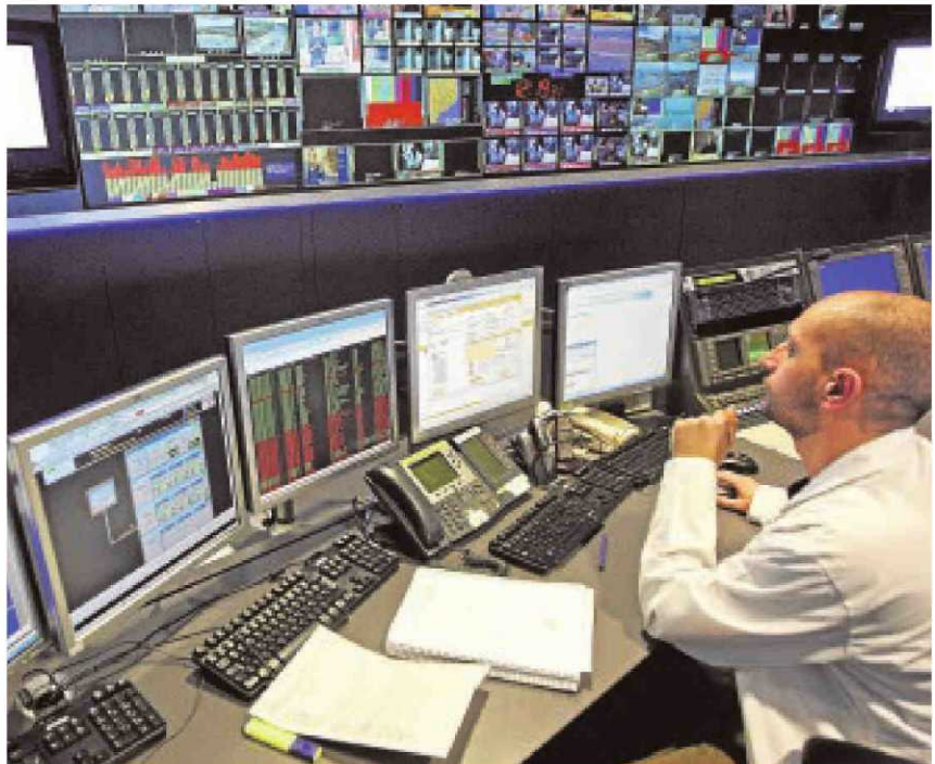
Sala del centro de control de TV3
