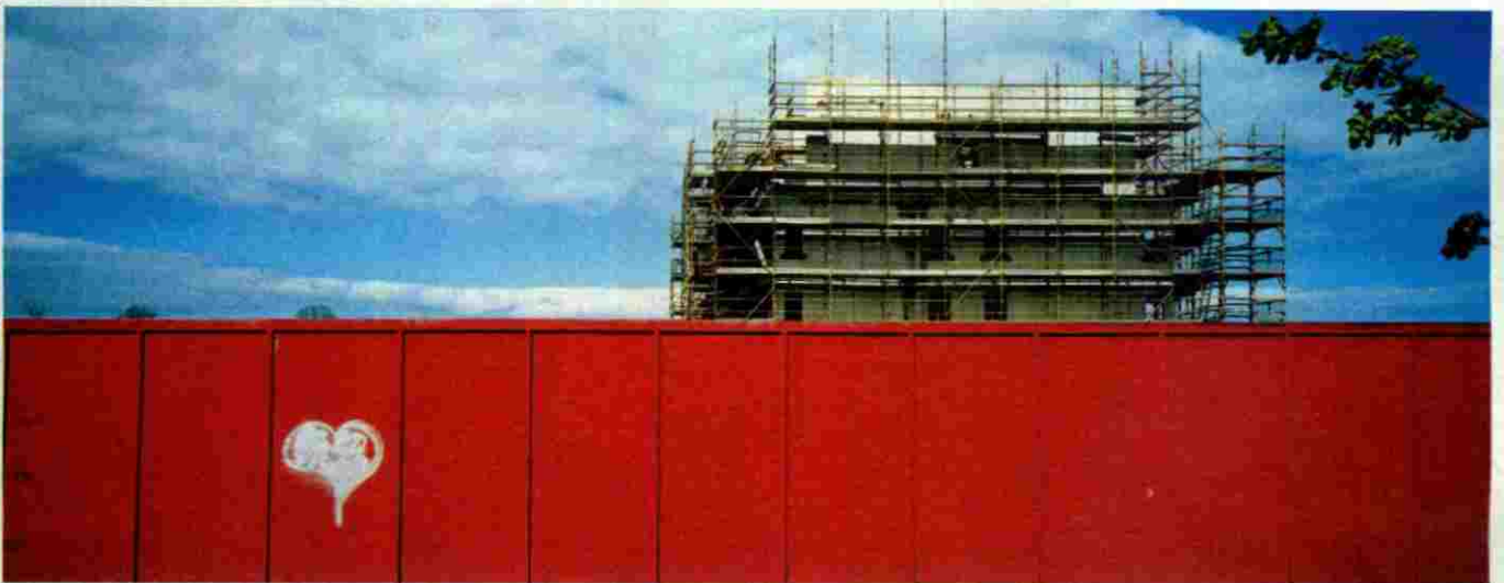
Edifici en obres (parades) a Port Marnoch, als afores de Dublin, Irlanda. Una mica d'amor entre tanta desolació.
