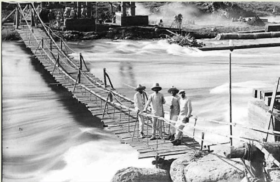
Filipinas, 1896. Construcción de un puente sobre el río Abra por la unidad de ingenieros del Ejército español
