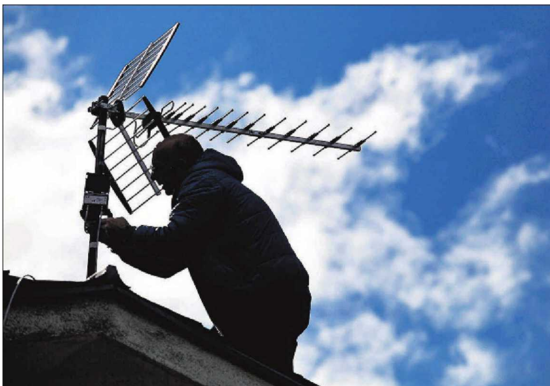
Un antenista cambia una antena antigua y resintoniza una nueva con amplificador. / SANTI BURGOS
