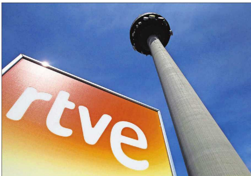
Sede de RTVE en Torrespaña, junto a la torre de comunicaciones. / CARLOS ROSILLO
