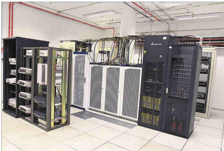
Instalaciones del nuevo Centro de Tecnología e Innovación de Telefónica.
